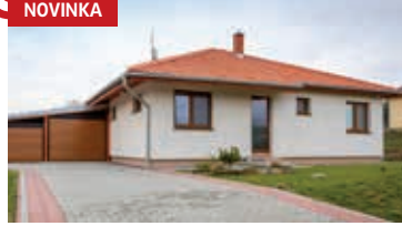
Novostavba RD Ořechov / okr. UH N09124
