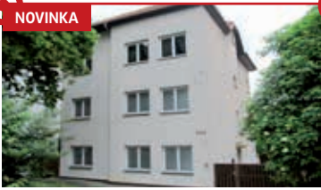
Komerční objekt Zlín - centrum N08773
