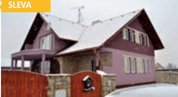
Novostavba rodinného domu Kunovice /okr. UH N07678
