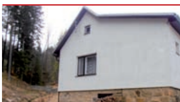
Držková /okr. ZL N06117 Zděný dům situovaný na konci obce, polosamota, pozemky cca 11.000 m², okamžitě obyvatelný. Kolaudace v r. 2002. tel.: 603 246 680 1.160.000 Kč
