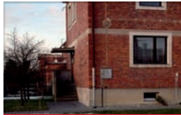
Rekonstruovaný 1/2 domek Otrokovice
