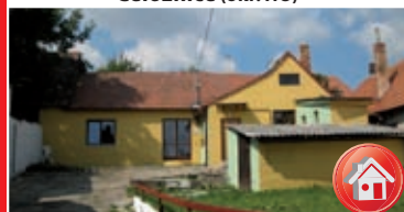
Čeložnice (okr. HO)
